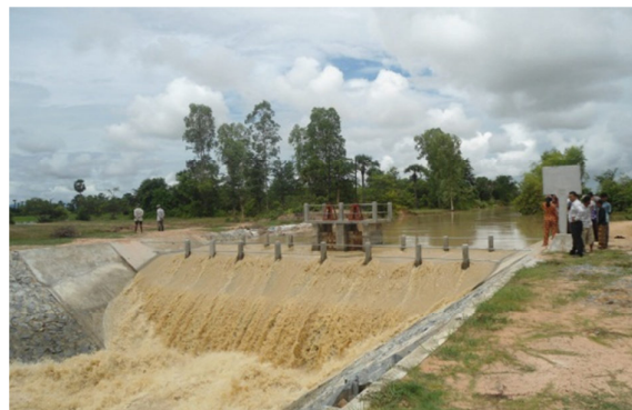
រូបភាព ៧ : ទំនប់បង្ហូរសាងសង់រួចរាល់ ដើម្បីរក្សាទឹកសម្រាប់ស្រោចស្រពក្នុងតំបន់គោលដៅ
